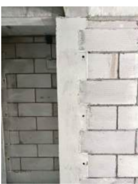
图三：构造柱样板
