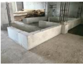
图一：导墙浇筑样板
