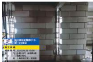
图二：墙体砌筑样板及构造柱预留样板
