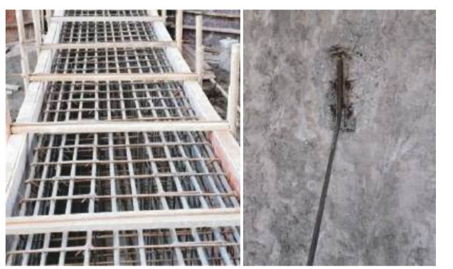
主筋分布均匀 吊筋焊接高度长度符合图纸要求
