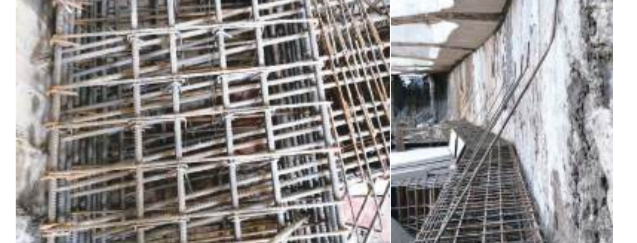
支撑锚入围檩长度符合设计要求 钢筋转角处按1:6施工符合要求
