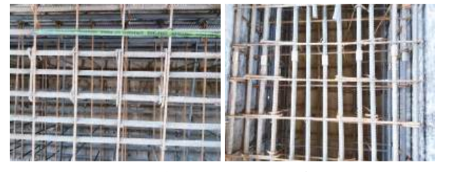
箍筋间距符合要求 钢筋套筒连接到位
