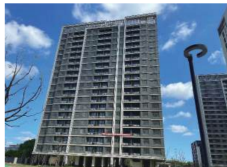
项目现场外立面
